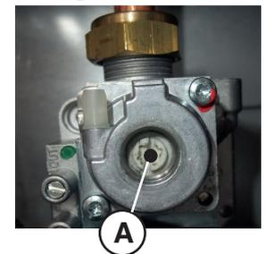
**B) РЕГУЛИРОВКА МИНИМАЛЬНОЙ МОЩНОСТИ**
