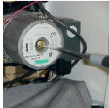
вставить отвёртку, вращая вал циркуляционный насоса по ходу часовой стрелки. Завершив операцию по разблокированию, закрутить защитный винт и убедиться в отсутствии утечек воды.
